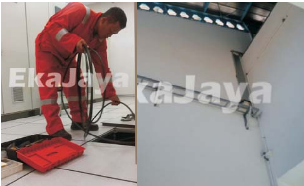
Instalasi Kabel FO dengan safety lengkap
